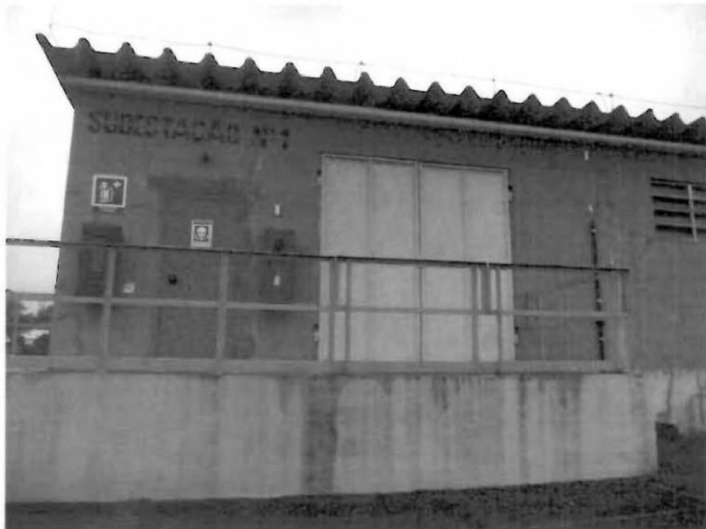
Nº.61 – Prédio da subestação nº.01 - CODESP
