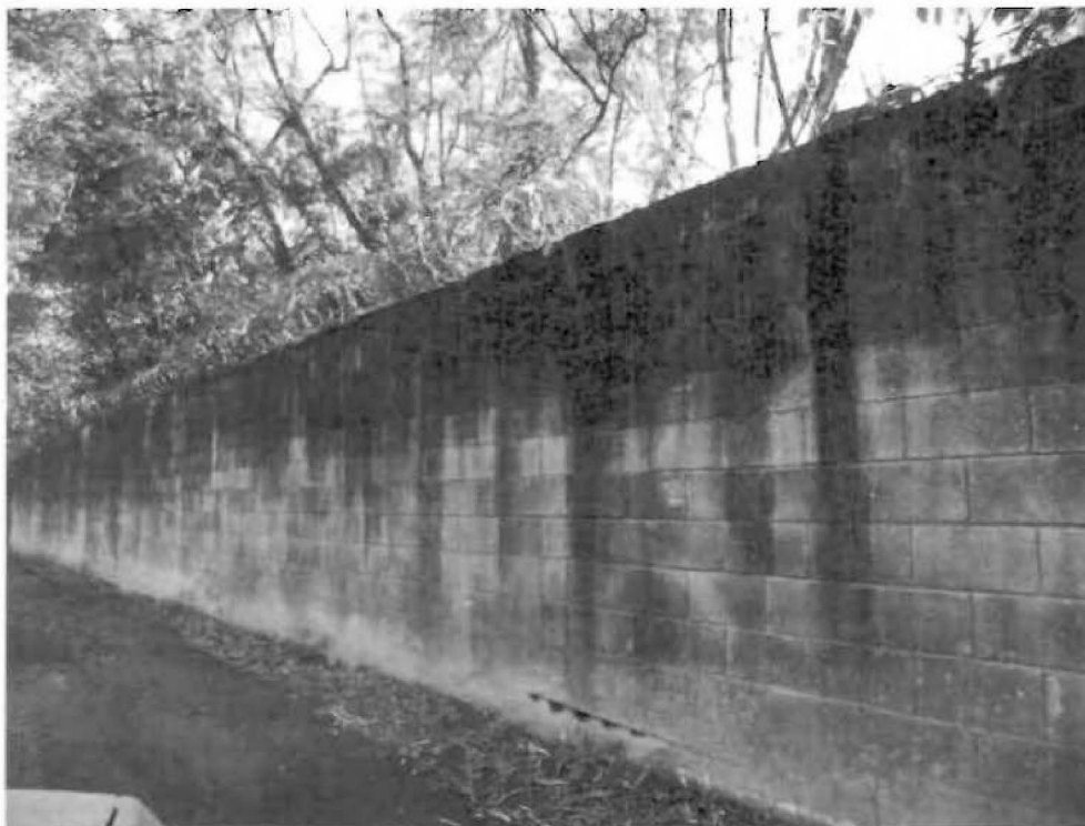
Nº.41 – Fechamento da área industrial
