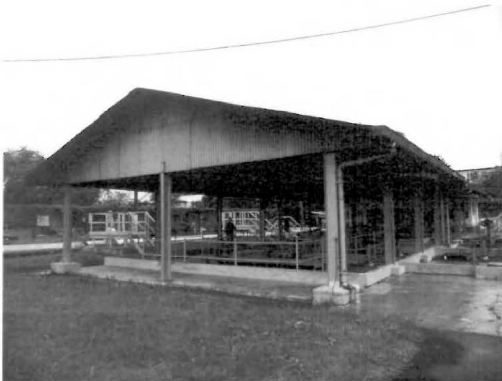
Nº.62 – Casa de Bombas Km0+540 - CODESP
