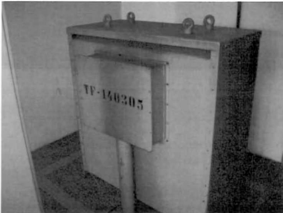
Nº 325-TF 140305- Transformador fabricação Easa, tipo à seco, 480/220V, 112,5 Kva.
