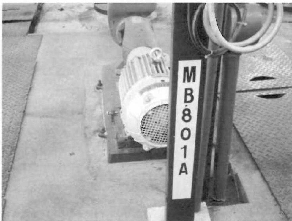
Nº 296- B- 451801 A/B- Bomba de 15 cv, vazão 50m 3 /h, motor Búfalo de 15 hp. (Área TDC).
