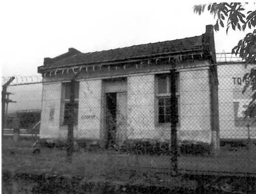
Nº.69(civil) – Edificação CODESP (ao lado TQ-631805)
