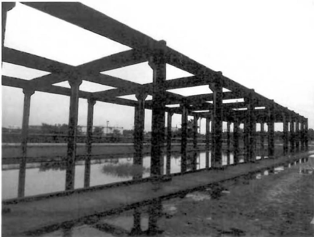
Nº.49 – Casa de bombas de diesel (inacabada)
