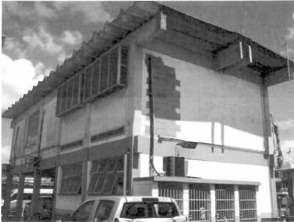
Nº.1 – Sala de Controle dos Operadores PIER (exterior)
