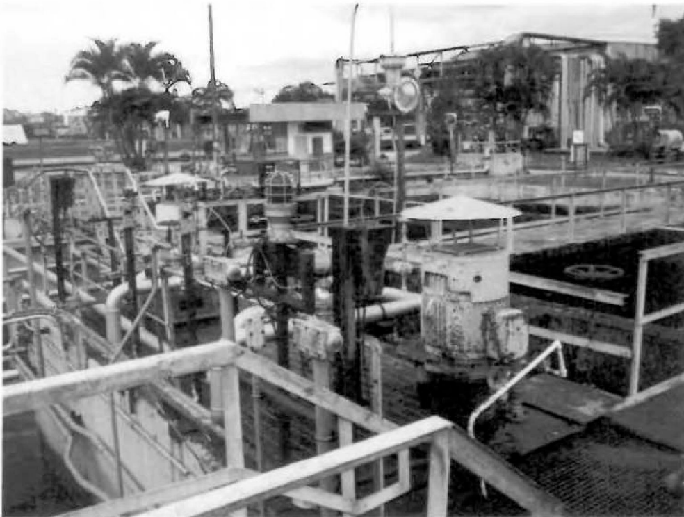
Nº 299/I- B- 464501B- Bomba de 40 cv, vazão 60m 3 /h, motor GE de 40 hp. (Área SÃO).
