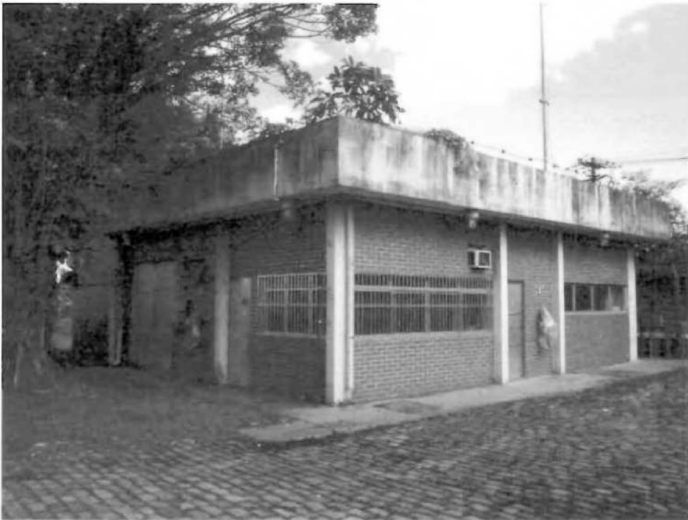
Nº.2 – Casa de bombas de Bunker (junto à CODESP)
