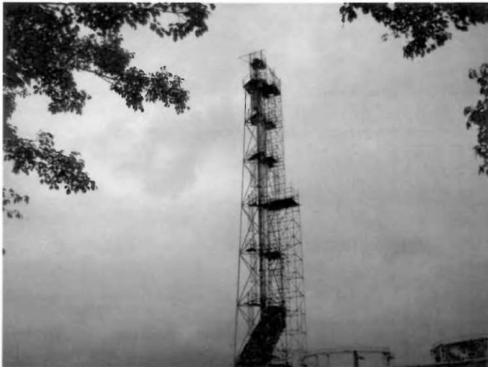
Nº 208- TC-01 A/B - Queimador de gás sem fumaça de diâmetro 18" SELMEC. (Área GLP-Flare).
