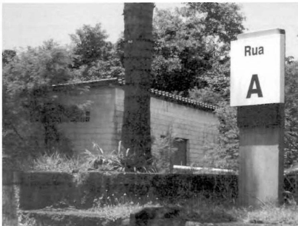
Nº.71(civil) – Depósito CODESP (Pátio Sucata)
