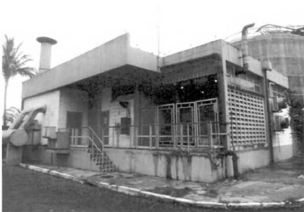
Nº.7 – Subestação 5A do Terminal do GLP
