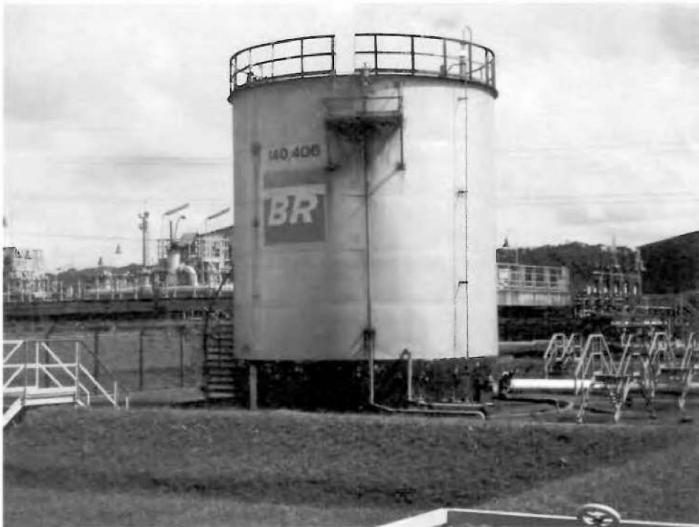
Nº 320- TQ 140406- Tanque de armazenamento de produtos escuros. Capacidade= 400m 3 (Área COTAL)
