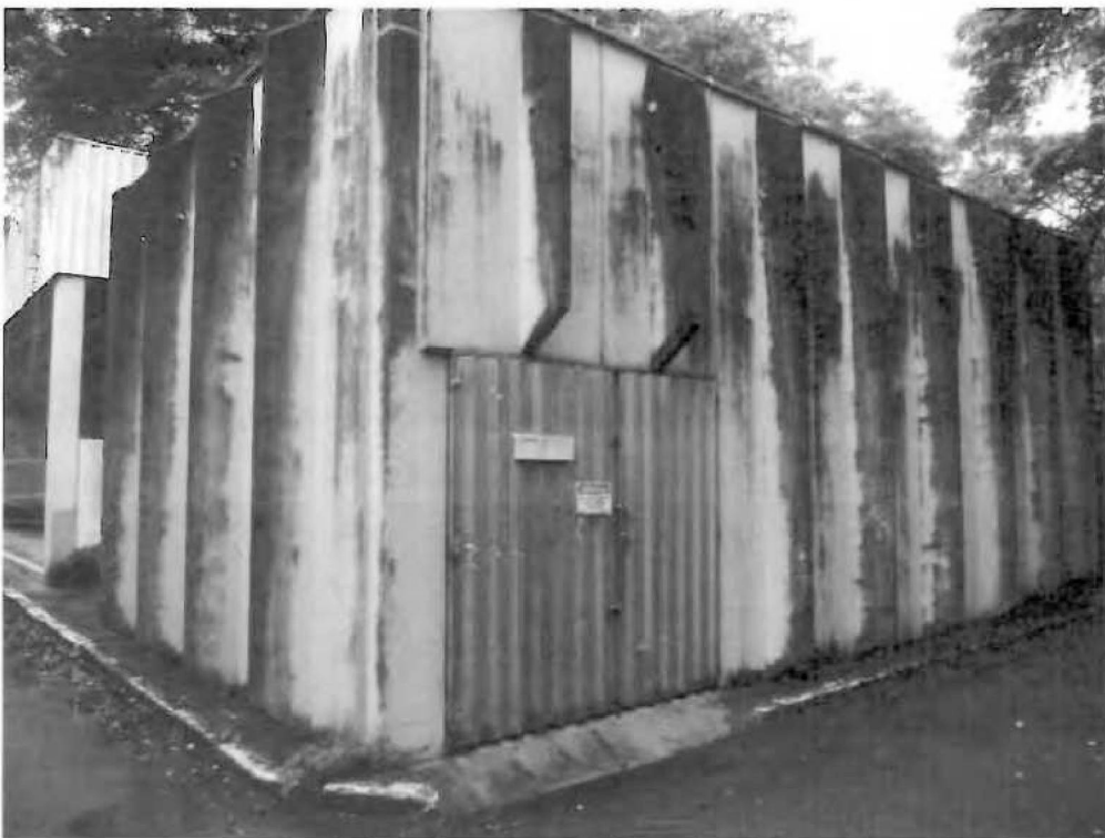
Nº.38 – Gerador e oficina do CRE
