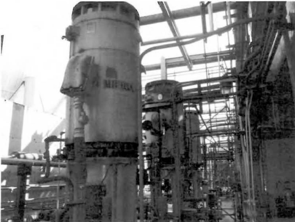
Nº 190- B-03 A/B/C-Bombas verticais Worthington, vazão 275 m 3 /h, Motor GE 300 HP (Área GLP).
