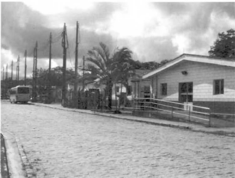
Nº.22 – Canteiro de obras
