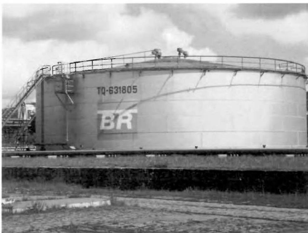
Nº 332- TQ 631805- Tanque para armazenamento de Bunker (MF-380 cst). Capacidade= 5.400 m 3 (Rua 1- Entrada da Área Industrial).
