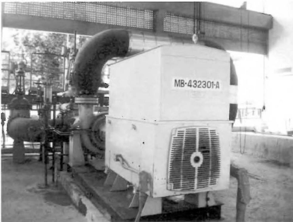
Nº 222- B-432.301/A- Bomba Sulzer cent. Horiz. de 700 cv, motor GE 700hp (Área do TDC).
