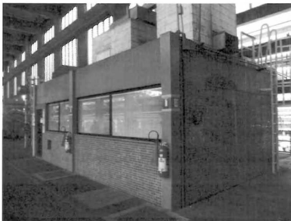
Nº.55 – Sala de controle na Casa de máquinas
