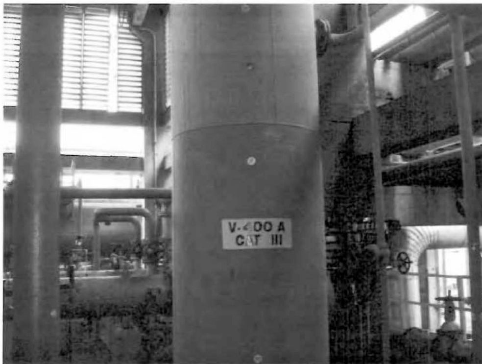
Nº110- V-400A/B/- Vaso Armazenador de ar. (Área GLP) Peso vazio: V-400 A= 1450 Kgs V-400 B= 5000 Kgs
