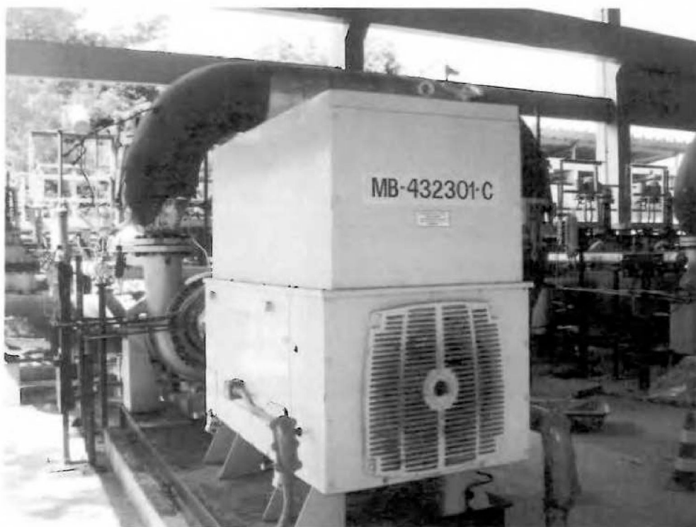
Nº 222/2- B-432.301/C- Bomba Sulzer cent. Horiz. de 700 cv, motor GE 700hp (Área TDC).
