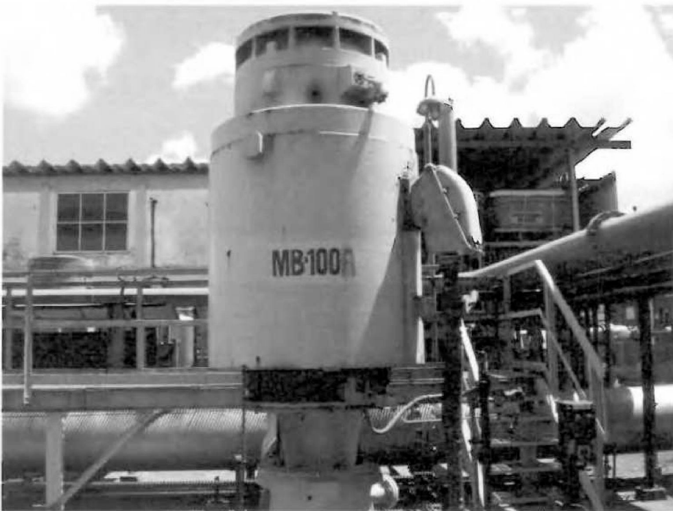
Nº125- MB- 100 A/B/C- Bombas Worthington – motor GE (Área do PIER).
