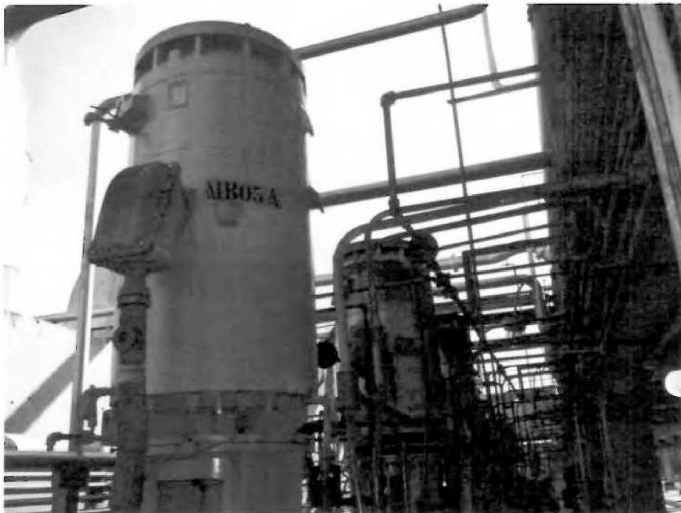
Nº 192- B-05 A/B/C- Bombas verticais Worthington, vazão 273 m 3 /h, Motor GE 300 HP (Área GLP).
