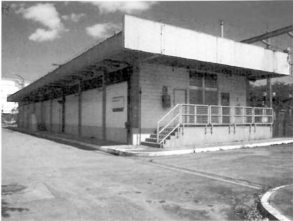
Nº.3 – Subestação 4A do TDC (exterior)
