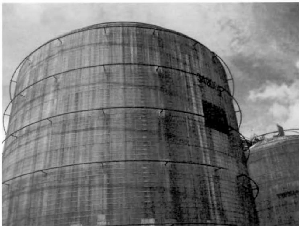
Nº 218/4- TQ- 349004- Tanques isolados para estocagem de GLP, 16.795 m 3 (Área GLP).
