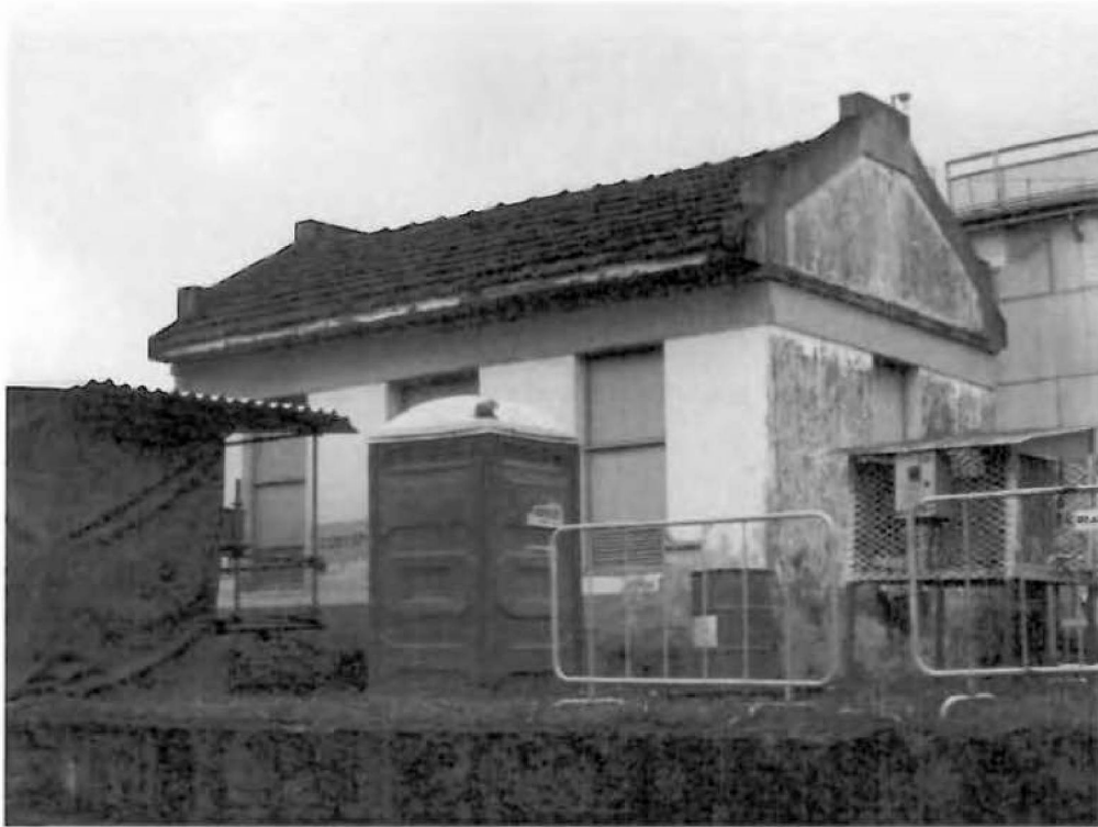
Nº.67 – Edificação CODESP (próxima ao TQ-631803)
