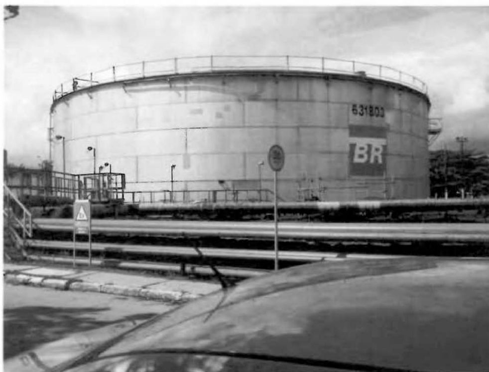
Nº 330- TQ 631803- Tanque para armazenamento de Bunker (MF-380 cst). Capacidade= 5.400 m 3 (Rua 1- Entrada da Área Industrial).
