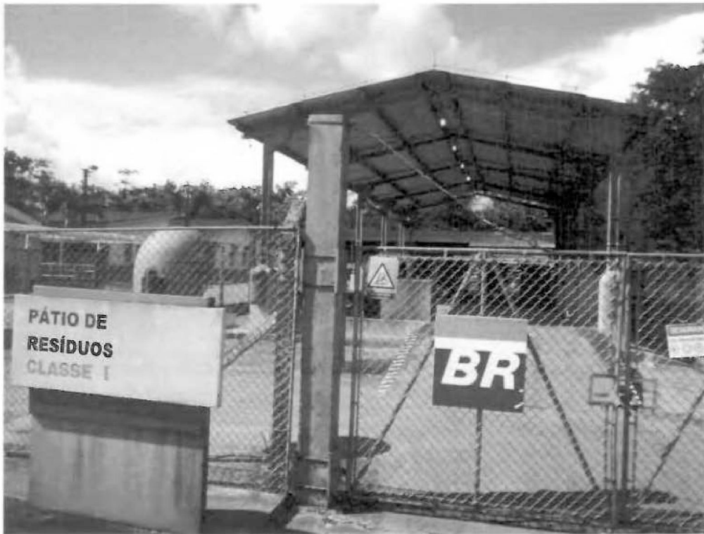
Nº.30 – Pátio de resíduos
