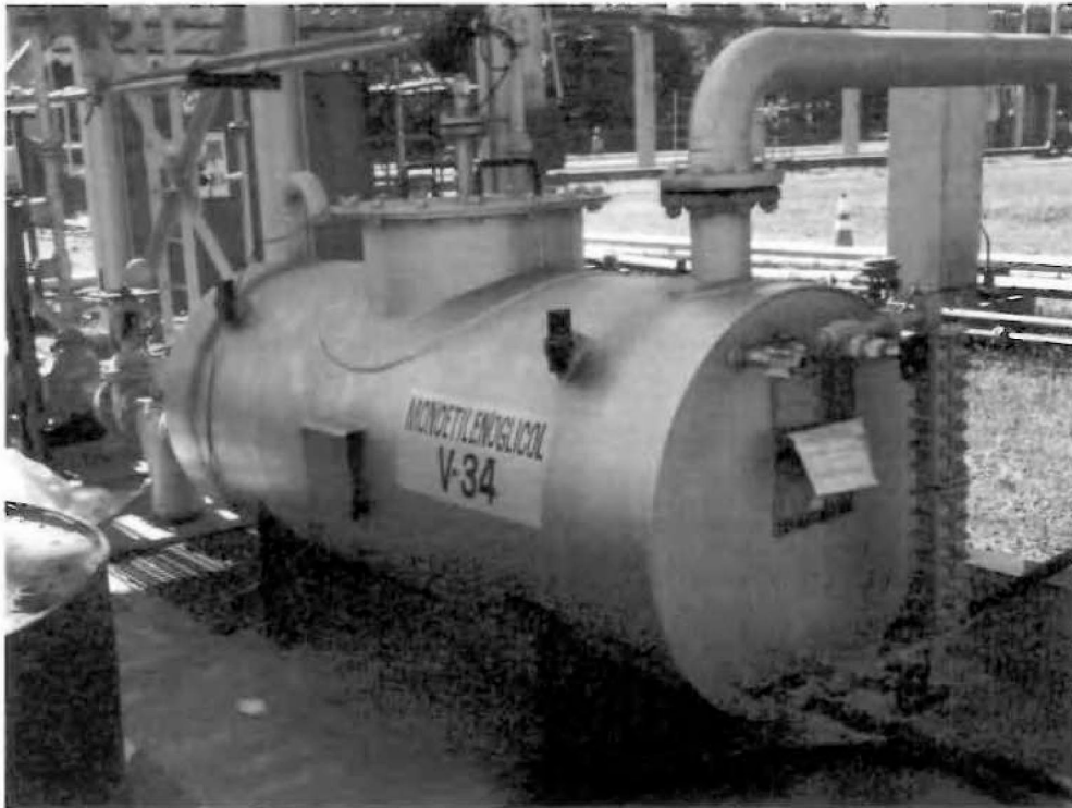
Nº 213- V-34- Vaso armazenador de etilenoglicol. (Área GLP).
