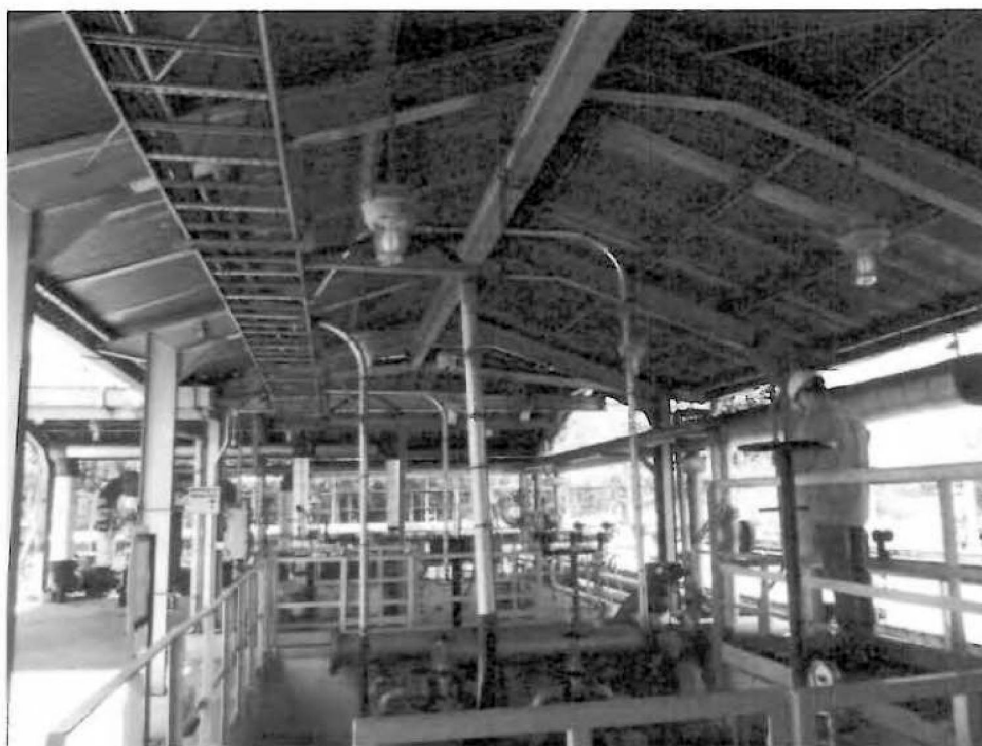
Nº.72(civil) – Casa de Bombas do Bunker (próx. à guarita)
