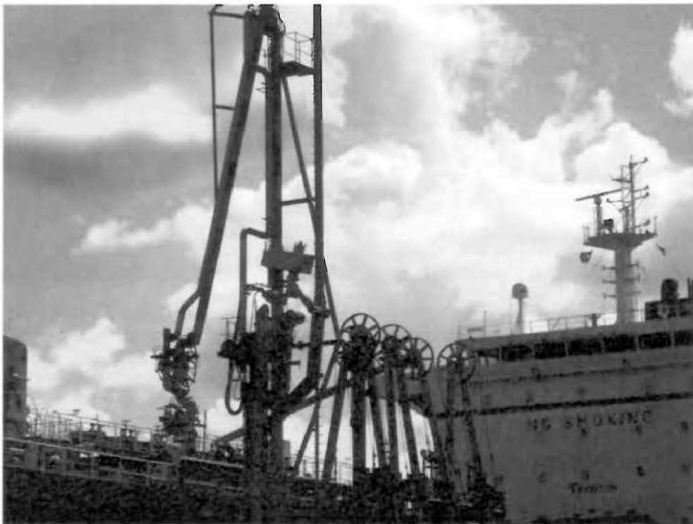
Nº 156- LA-02-A (BC- 28001ª)- Braço de carregamento FMC.-Ponto 1 (Área PIER).
