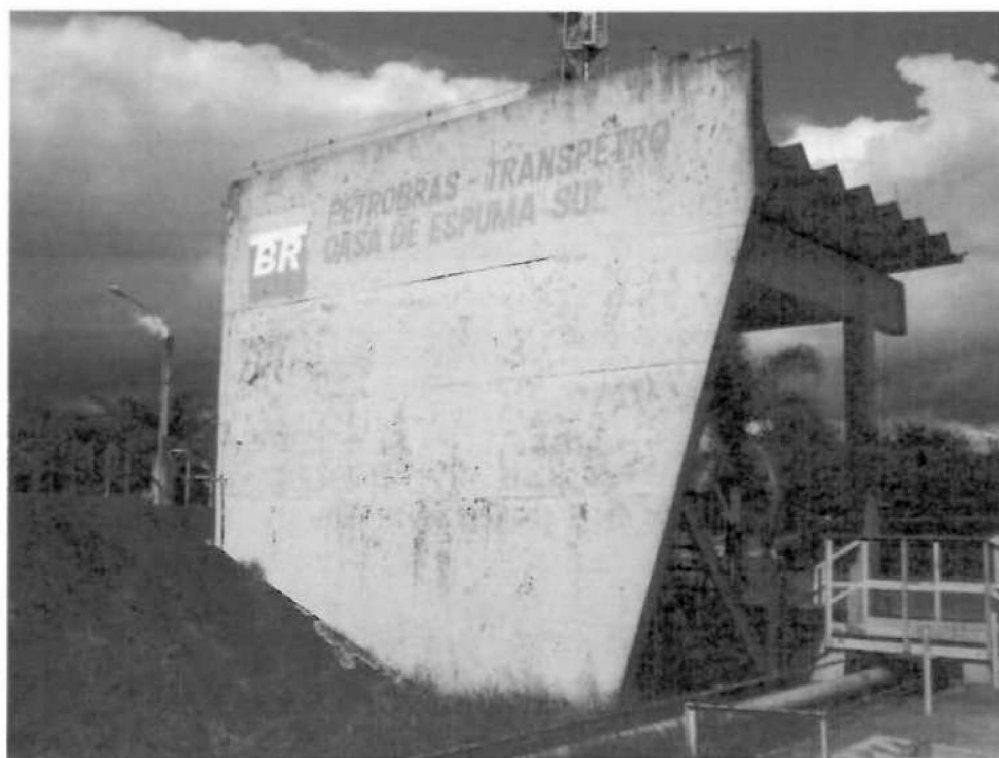
Nº.16 – Casa de espuma Sul
