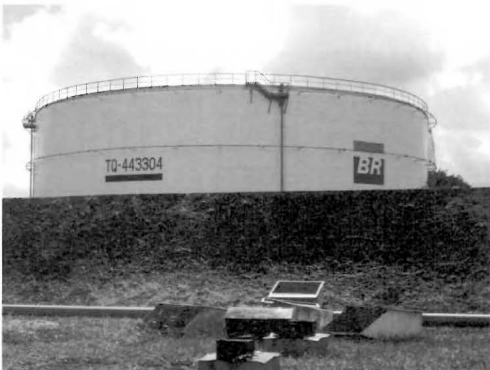
Nº 307/3- TQ 443304- Tanque para gasolina, sem agitadores Cap. 22.469 m3 (Área TDC).
