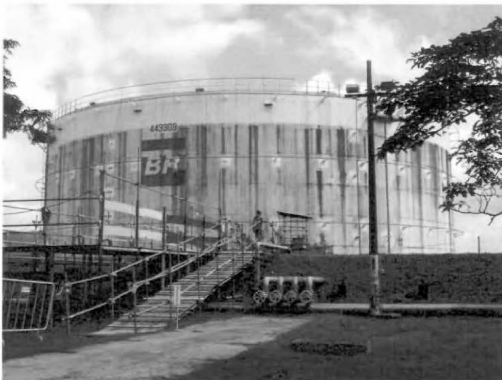
Nº 309/2- TQ 443309- Tanque para armazenar álcool e gasolina. Capacidade= 20.000 m 3 (Área COTAL).
