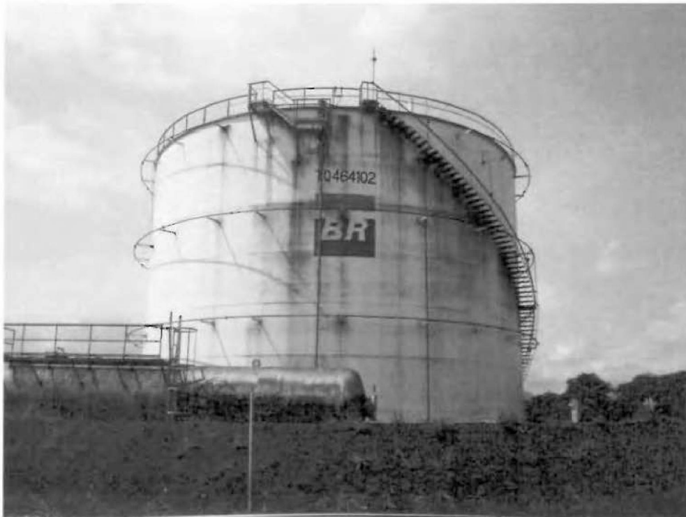
Nº 305-TQ 464102 - Tanque para Slop com capacidade de 489m 3 e diâmetro de 7,70m teto fixo.
