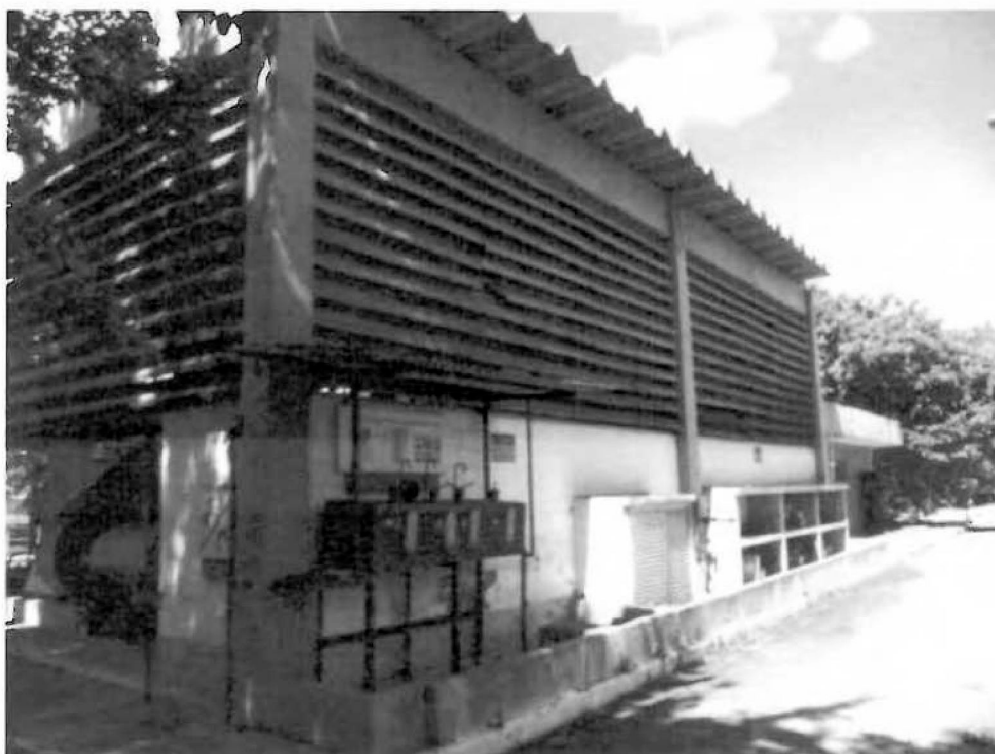
Nº.10 – Casa de Caldeiras
