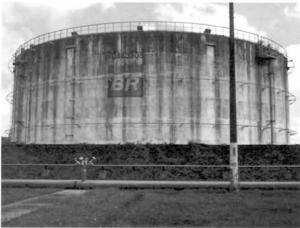
Nº 309/1- TQ 443308- Tanque para armazenar álcool e gasolina. Capacidade= 20.000 m 3 (Área COTAL).
