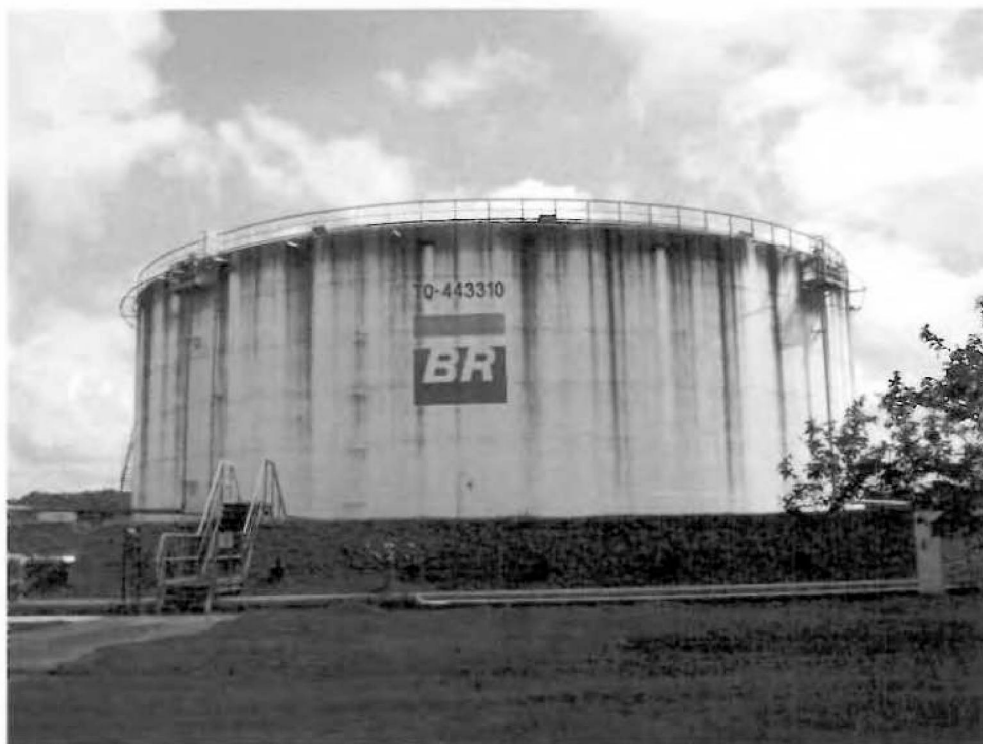
Nº 309/3- TQ 443310- Tanque para armazenar álcool e gasolina. Capacidade= 20.000 m 3 (Área COTAL).
