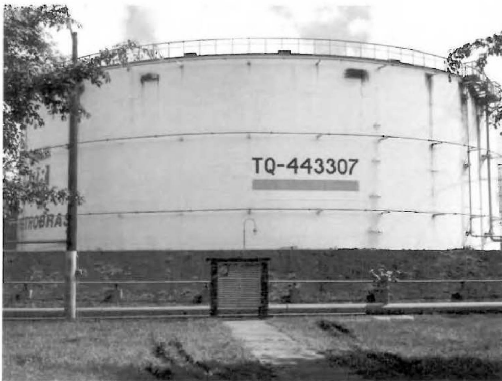
Nº 309- TQ 443307- Tanque para armazenar álcool e gasolina. Capacidade= 20.000 m 3 (Área COTAL).
