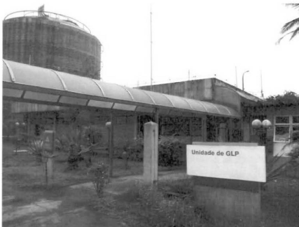
Nº.52 – Casa de controle do setor de gás
