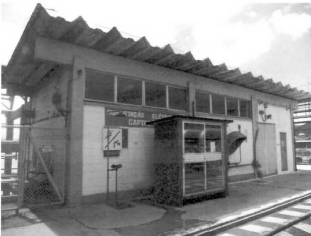
Nº.48 – Prédio da subestação e da captação (Pier)
