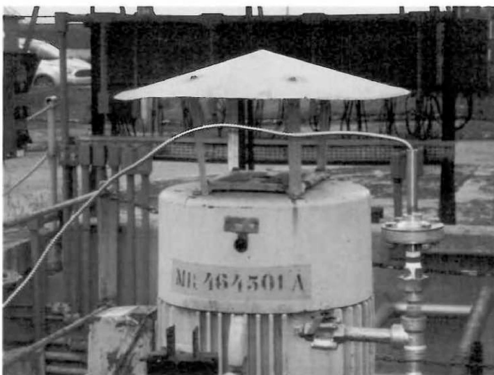
Nº 299- B- 464501 A- Bomba de 40 cv, vazão 60m 3 /h, motor GE de 40 hp. (Área SÃO).
