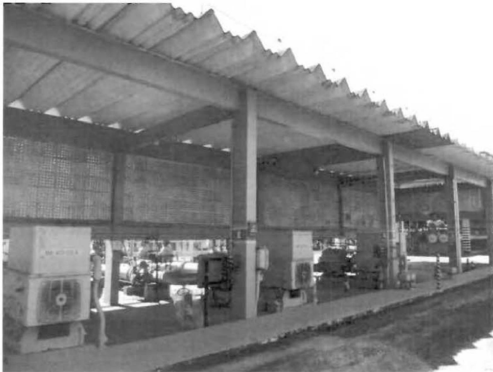
Nº.12 – Casa de bombas de álcool
