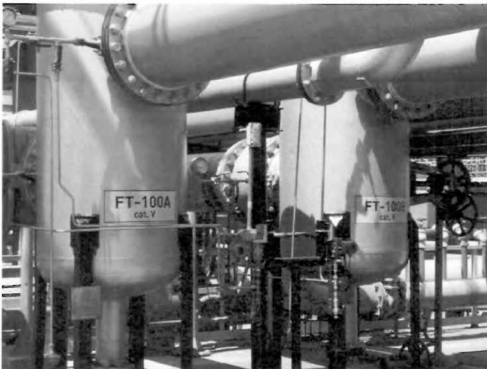
Nº126- FT-100 A/B – Filtros marca HERO (sis. de refrigeração-água do mar)-PIER Peso vazio= 1400 kgs
